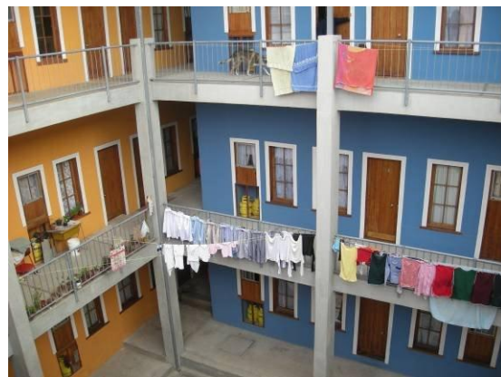
La Población Unión Obrera en cerro Cordillera, construida en 1898, fue la primera vivienda social de Chile
